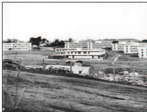
Le Village Méditerranéen en cours de construction
